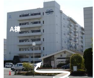
②安田倉庫守衛を通過付近
